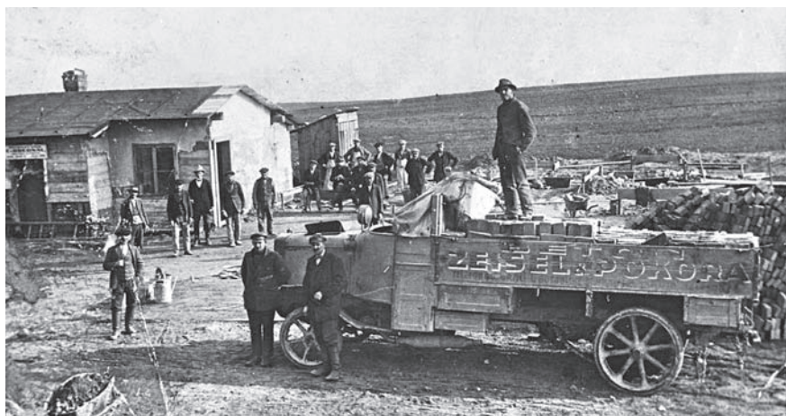
Počátek stavebních prací
